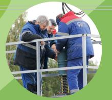
Электромонтеры ведут работы на вторичном отстойнике. Ремонтируют токосъемник.
